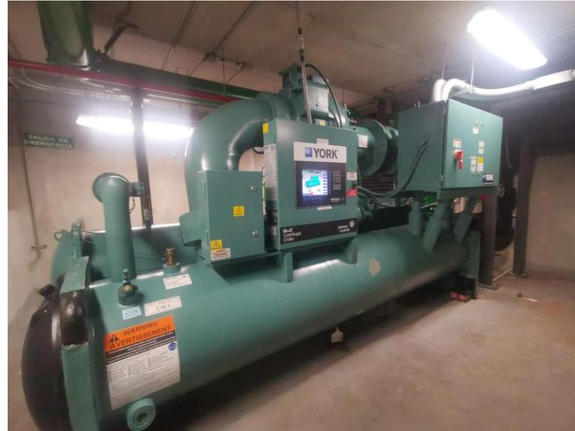
Sistema Chiller de agua Helada para aires acondicionados. Solamente acá es donde se utiliza gas refrigerante, en los equipos de A/C de cada oficina o aposento trabajan solamente con agua.
